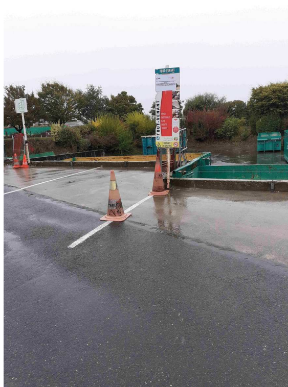
quais_sans_dispositif anti-chute
